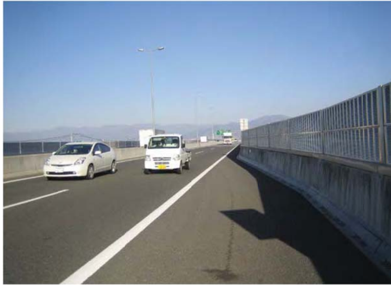
① 韮崎南アルプス中央線 供用状況(玉穂中央ランプ付近)
