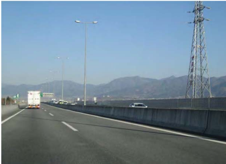
③ 韮崎南アルプス中央線 供用状況(下河東地区)
