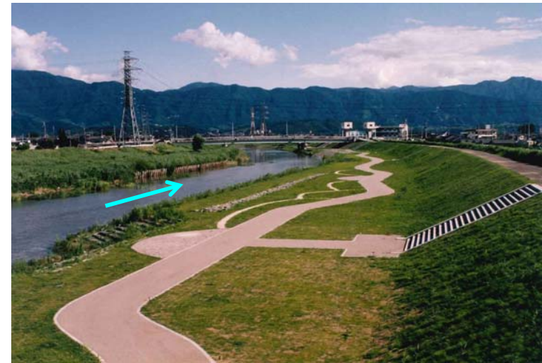
完成後（高水敷整備）
