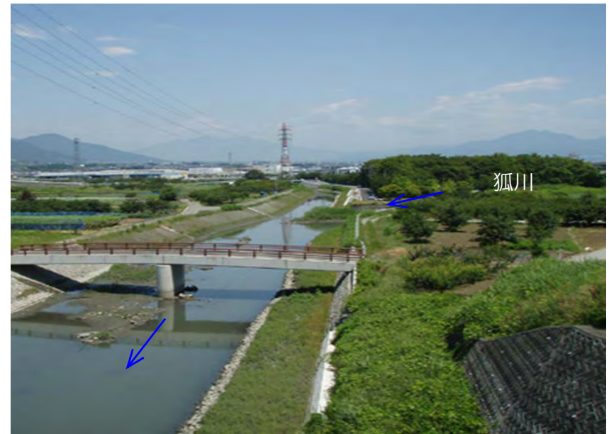
写真② 五明橋より上流方向
