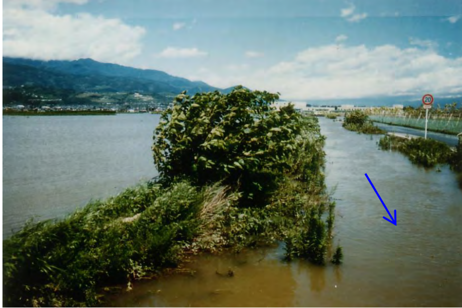
写真① 五明橋から上流の様子（昭和58年8月洪水）
