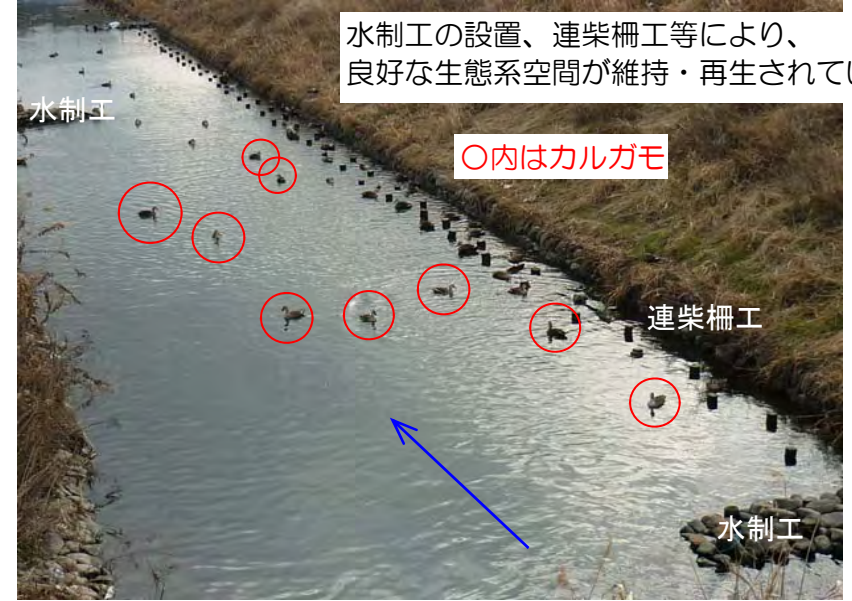
写真⑤ 五明1号橋下流水制工・連柴柵工とカルガモの様子
