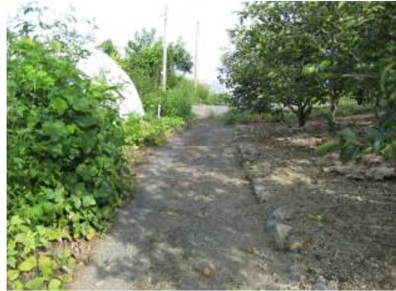
②未整備で車幅も狭く、農産物の運搬に支障をきたしている
