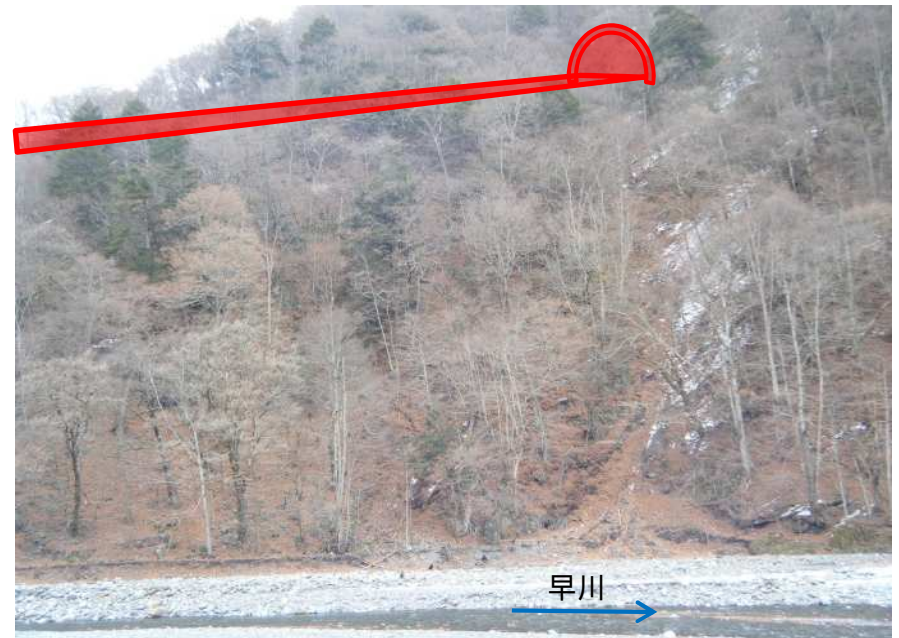
早川側 早川～トンネル坑口付近
