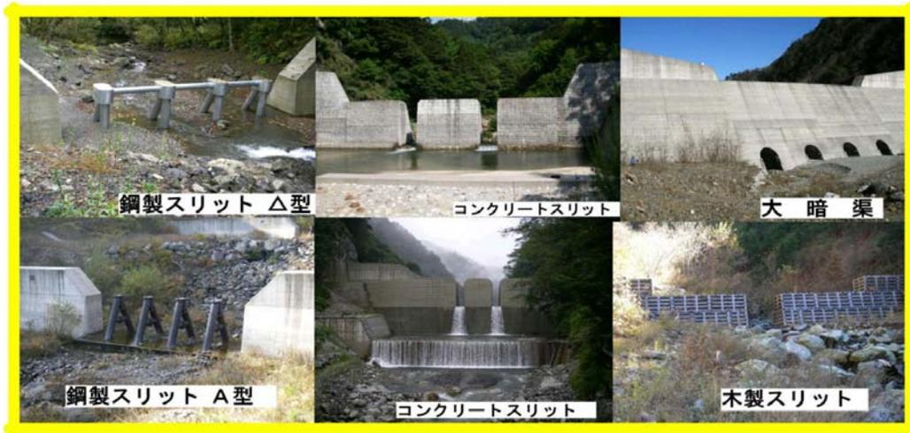
写真1 透過型堰堤の型式(鋼製スリットにはこれ以外にも色々なタイプがある)
