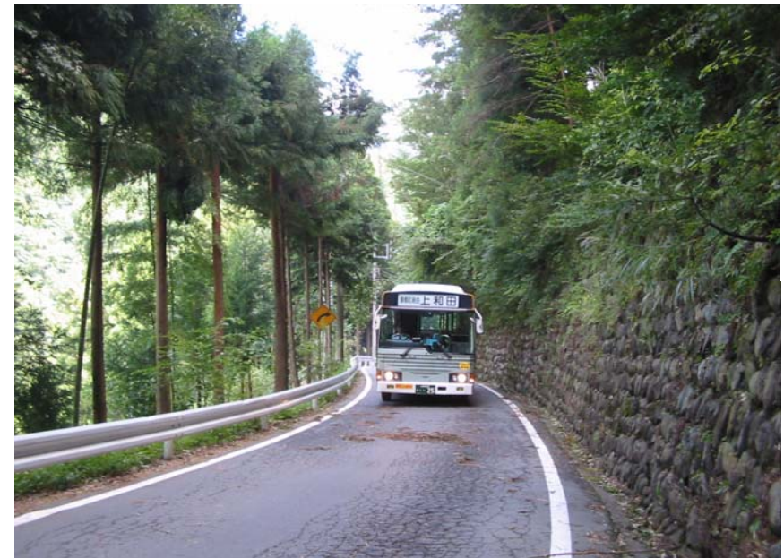
④ 現道の状況(幅員狭小)
