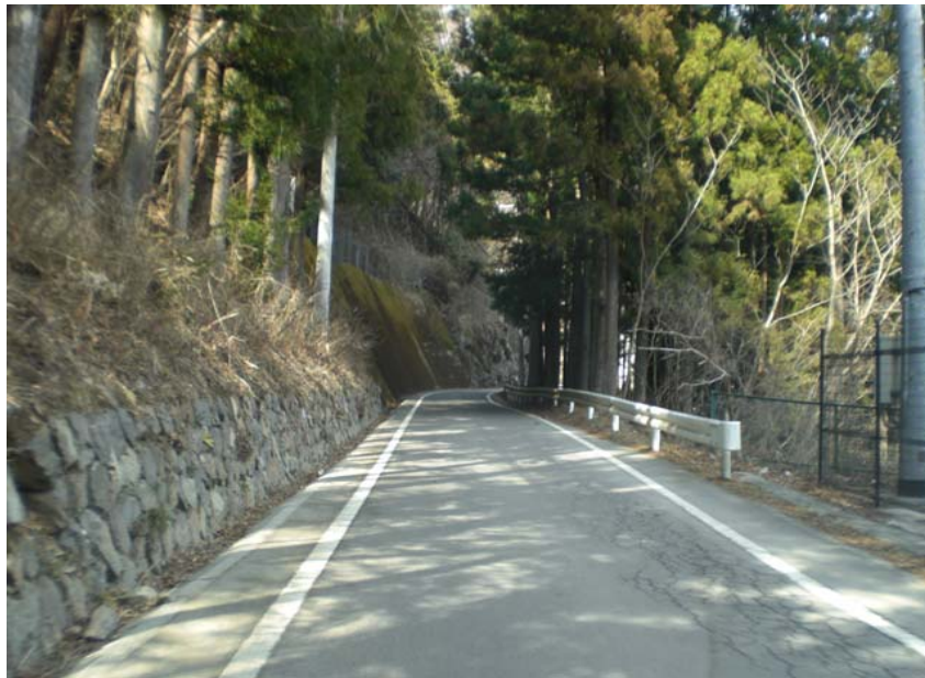
③ 現道の状況(線形不良、幅員狭小)
