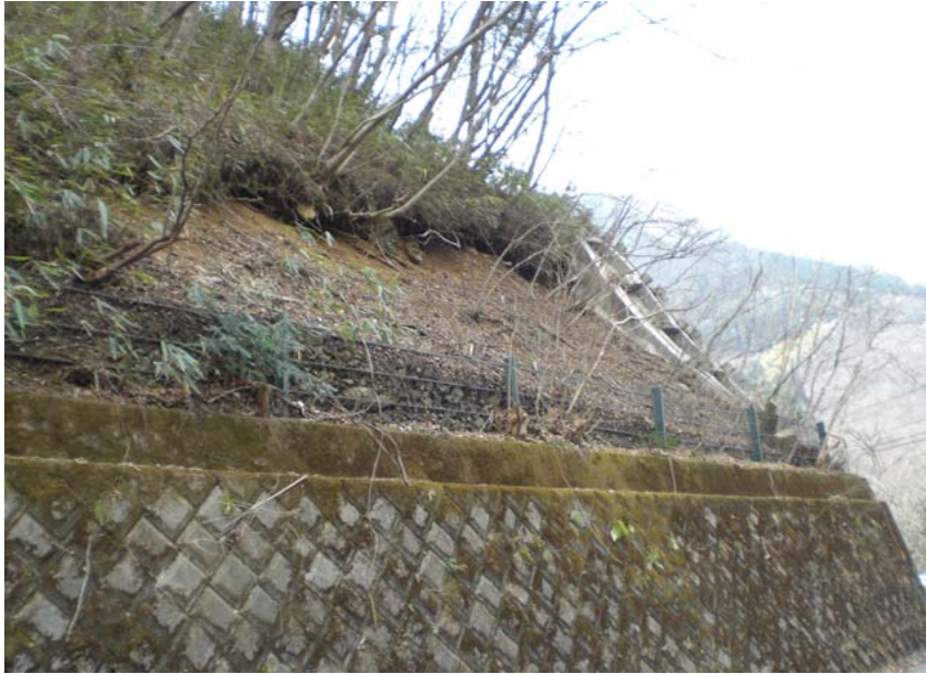
① 現道法面の状況(要対策箇所)
