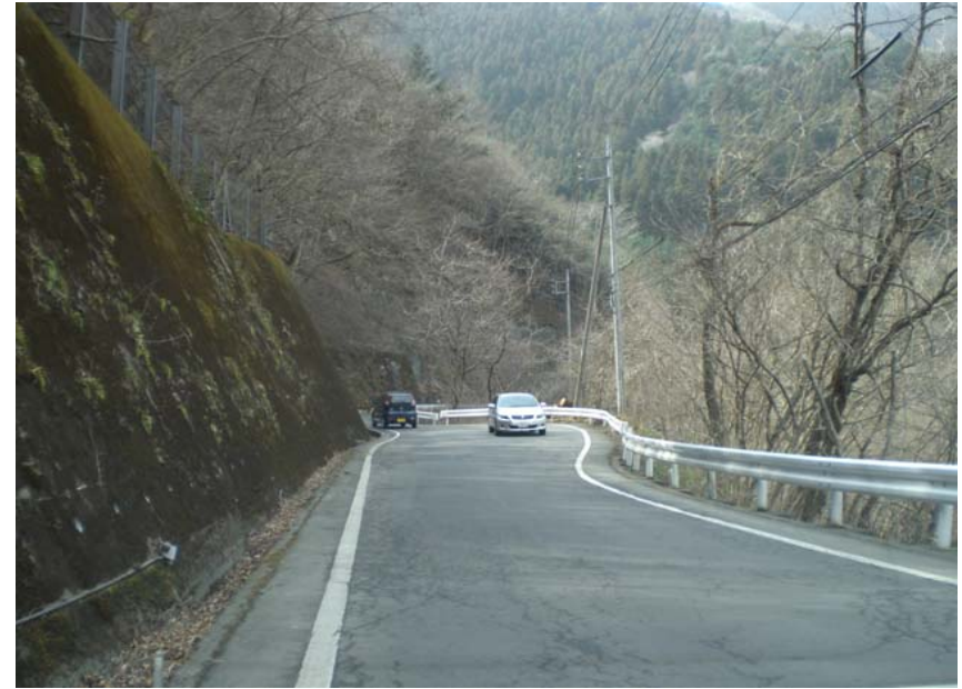
② 現道の状況(線形不良、幅員狭小)
