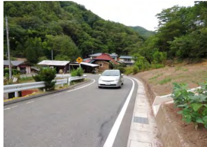
③現道 ヘアピンカーブ、幅員狭小箇所
