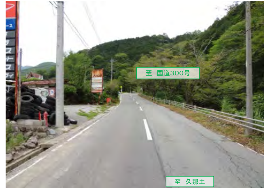
④現道 終点部
