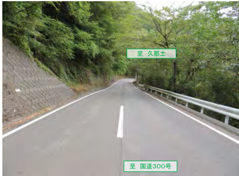
①現道 起点部
