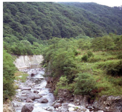
写真 新国界橋下流方向
