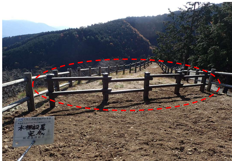
⑥ 木柵設置状況(進入禁止用) 近景
