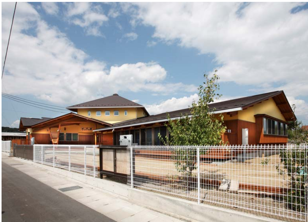
西側からの全景
