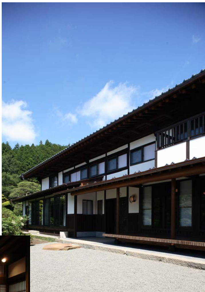
南東からの全景
