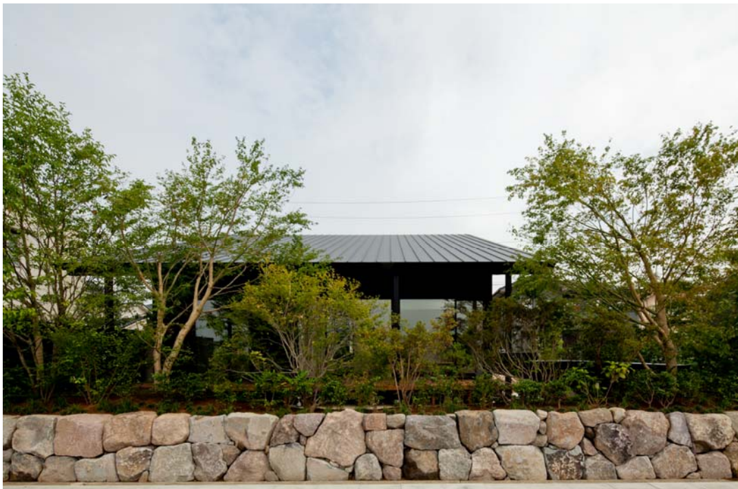
南側からの全景
