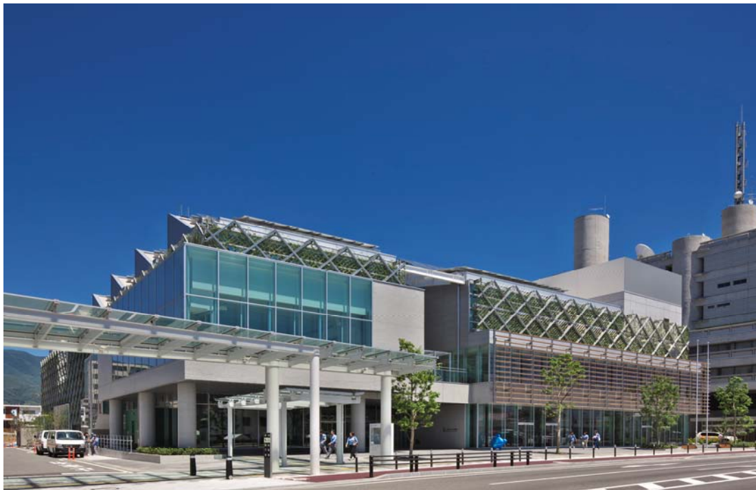
南側からの全景
