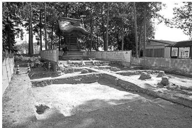
拝殿下盛土掘削状況
