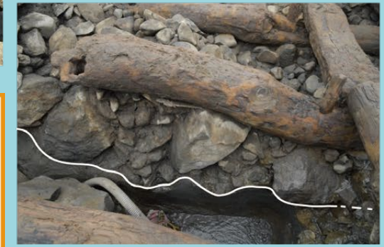
ゆるい地盤を掘って石を詰めた根切り
