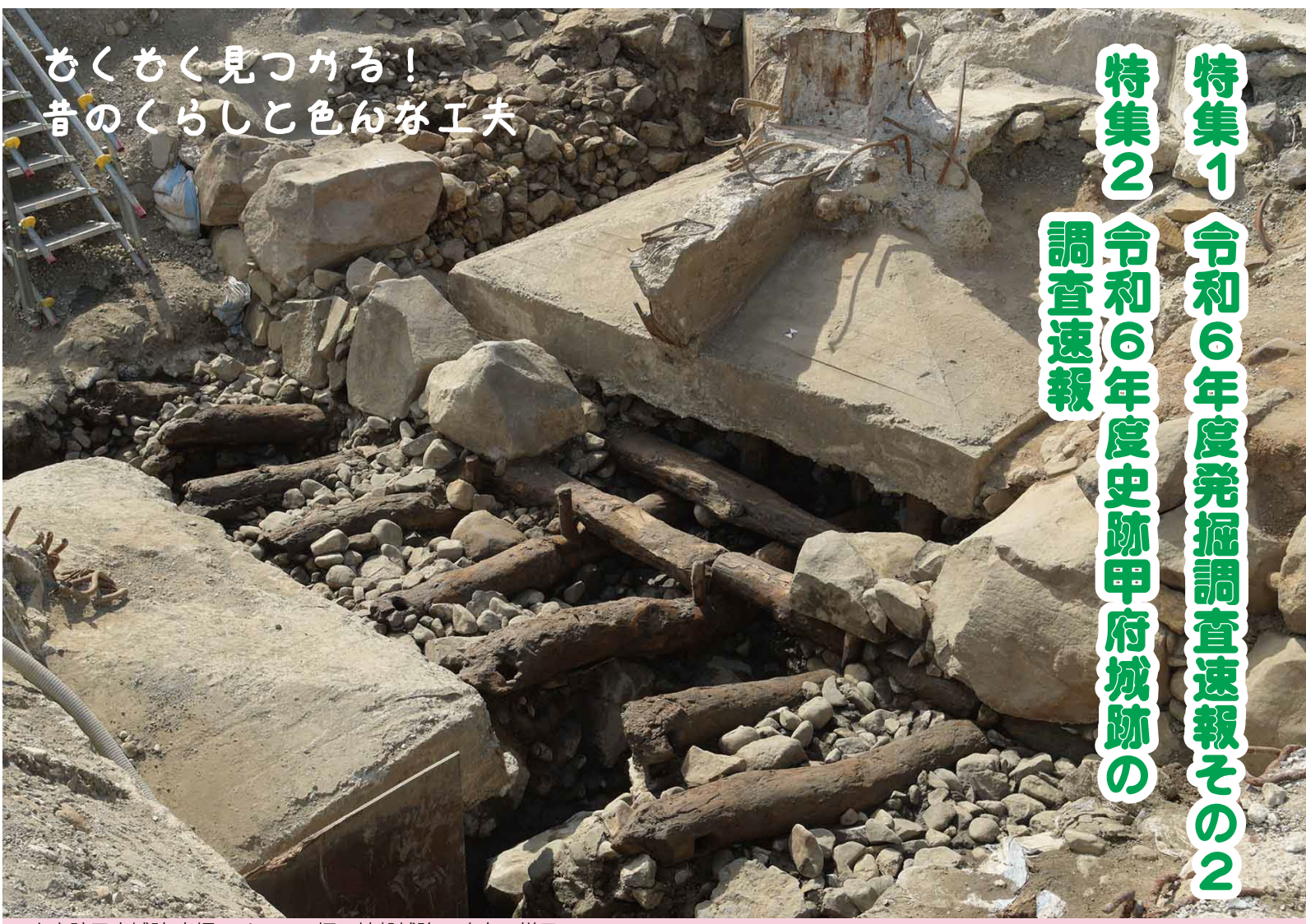
↑史跡甲府城跡 内堀エリアの石垣の地盤補強・改良の様子
