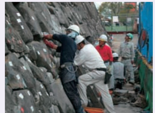
補修工事の様子
