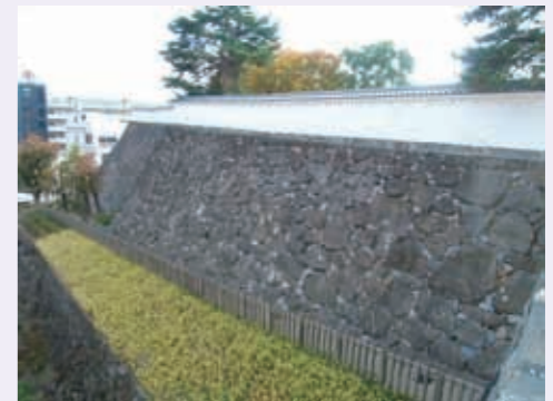
補修工事後の石垣
