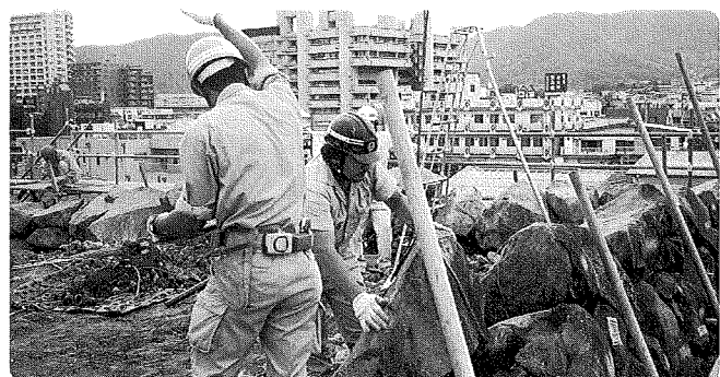
石垣を解体している作業のようす
