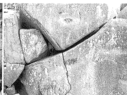
上の重さに耐えきれず大きく割れた石材
