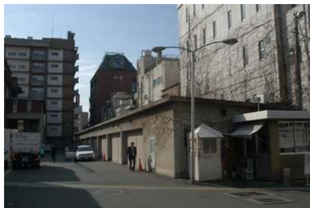
立体駐輪場建設予定地（第一車庫）
