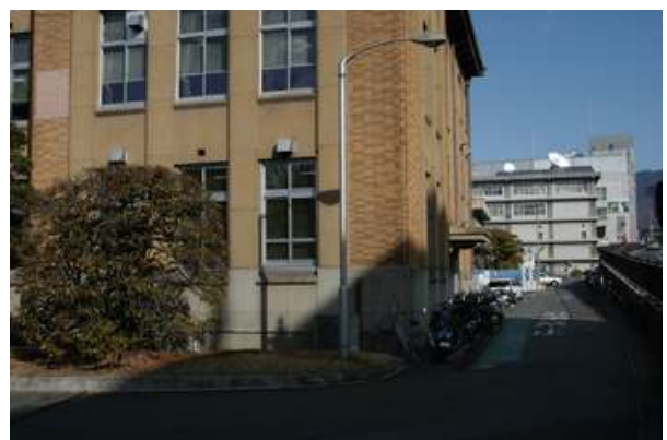
狭隘な別館東南角部
