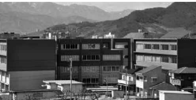
東側から見た校舎
