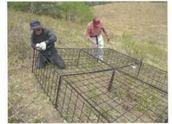
植生保護柵の設置
