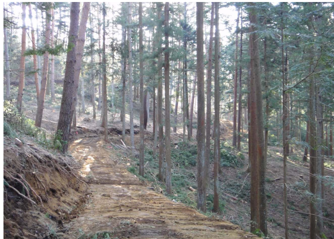
間伐・森林作業道開設状況
