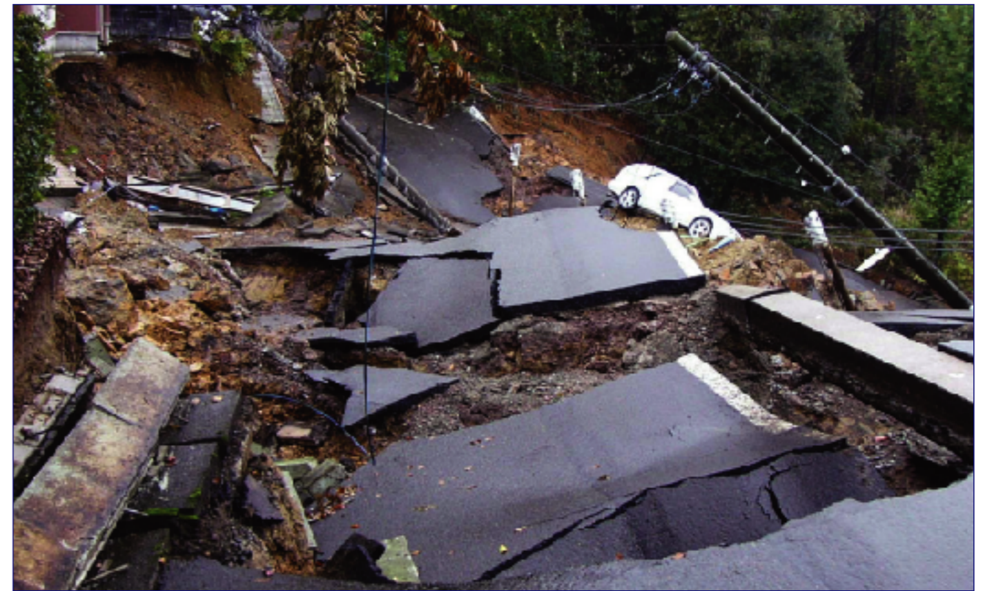
新潟県中越地震による被害
