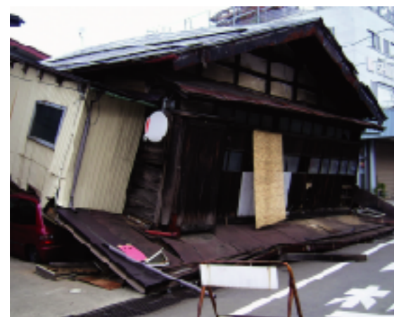
新潟県中越地震により倒壊した家屋
