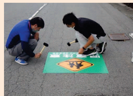
歩行者横断注意喚起シートの設置
