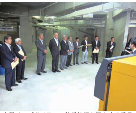
木質チップボイラーの稼働状況を調査する委員
