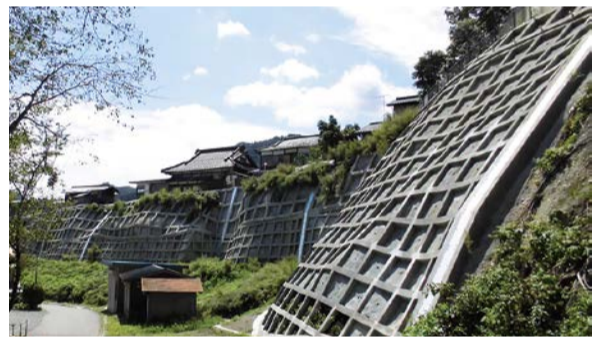
工事が完成した崩壊復旧事業
