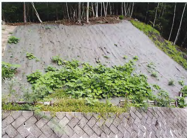
▲ 図 種子なし養生マットの試験施工地
