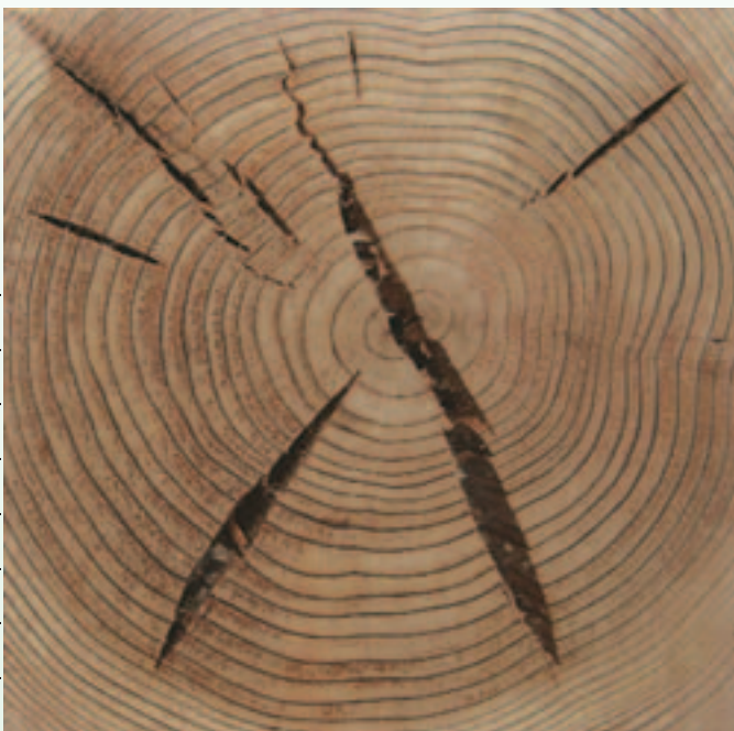
人工乾燥により生じた内部割れの様子
