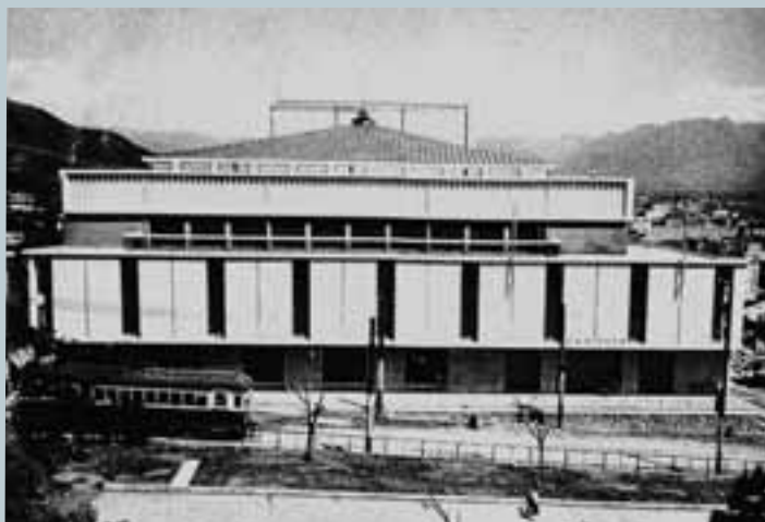
昭和32年に完成した山梨県民会館公会堂。正面左手をボロ電が走っている。
