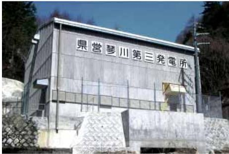
琴川ダム建設に伴い、琴川第三発電所の取水口が水没することとなり、琴川総合開発事業に合わせダムの放流水と落差を有効に利用した既存発電所の再開発を行いました。
