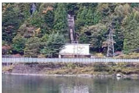
建設工事は奈良田第一発電所とともに進められ同時に完成しました。昭和34年8月台風7号の際に建設中の発電所基礎が埋没流失したため、当初計画地点より約1.5km下流の現在地に変更し、建設されました。県営唯一のカプラン型水車を使用し、西山ダムへ直接放水しています。
