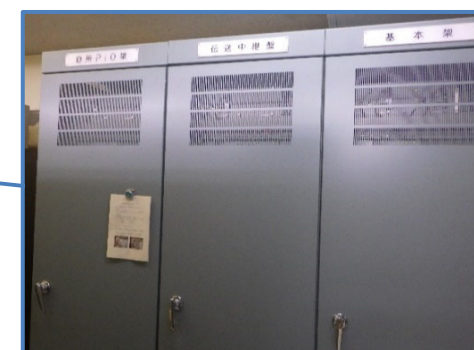
笛吹川水系発電管理事務所 伝送中継盤等更新
