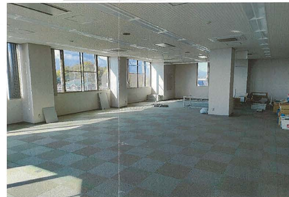
3F改修工事:書庫⇒事務室_発電総合制御所
