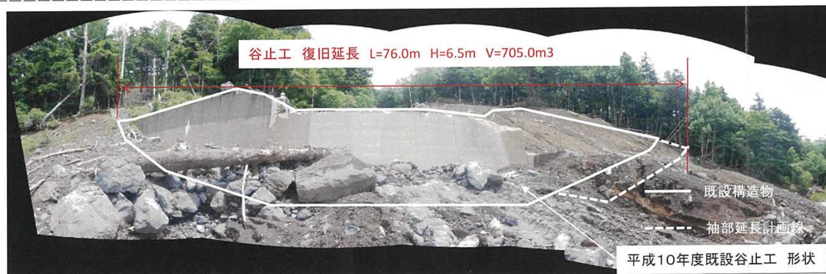
No. 2谷止工 (コンクリート) 構造図
