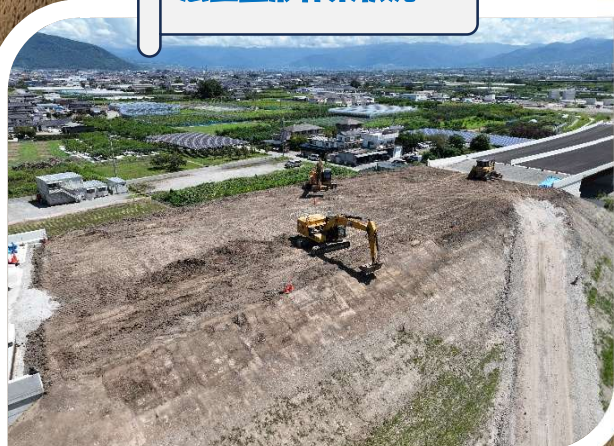
ICTバックホウによる 法面整形作業状況
