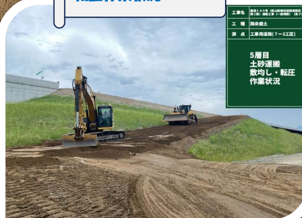
ICT重機による敷均し 転圧作業状況
