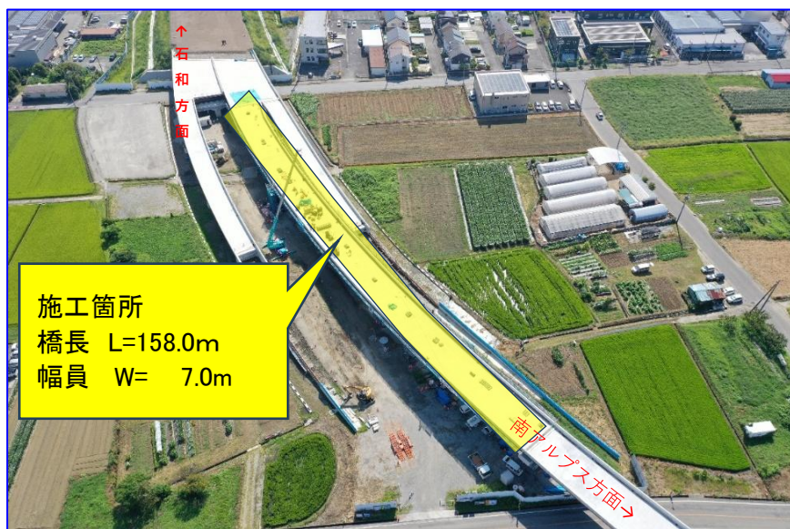
工事施工箇所
