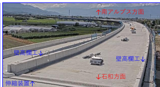
壁高欄工施工状況
