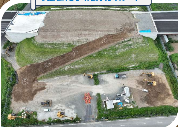
工事用道路・路床盛土工 5層目完了（路床厚1.0m）
