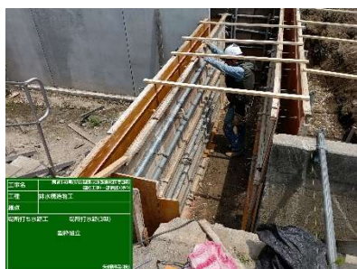
場所打水路工 型枠製作
