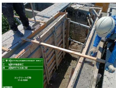
場所打水路工 生コン打設
