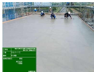
場所打函渠工 生コン打設
