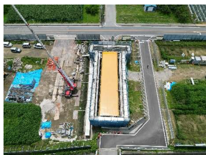
場所打水路工 型枠製作
