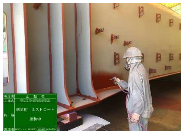
橋梁製作状況
