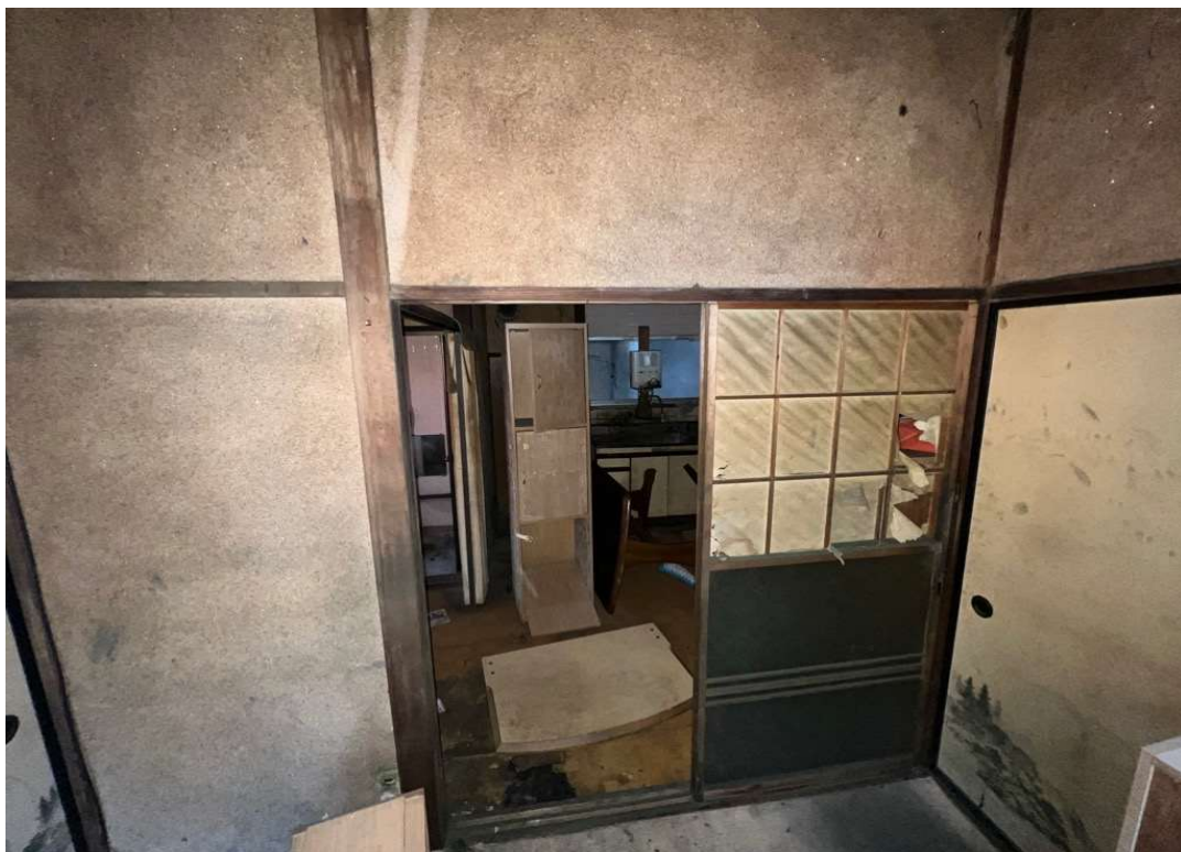
㊤対象物件内和室 2 北東方向
