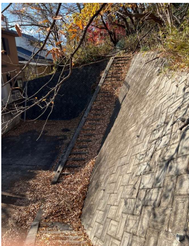
⑫対象物件法面階段（下り）
