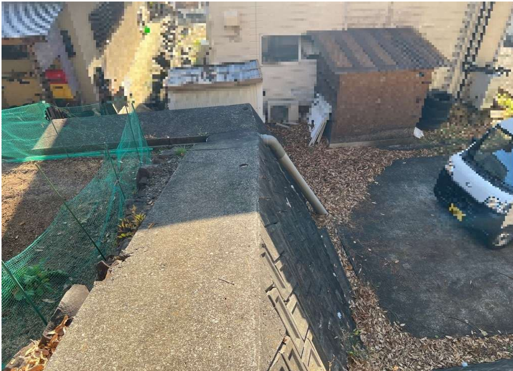
⑨対象物件法面上より南方向
