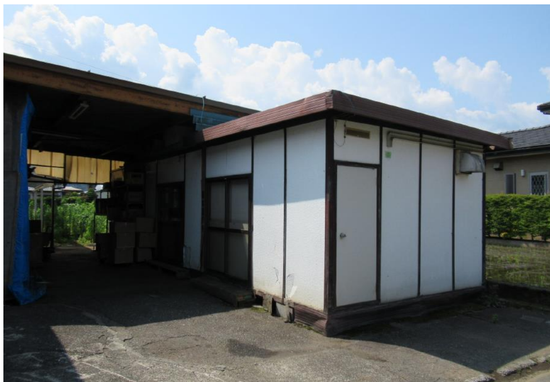
③ 物件を北側から撮影
