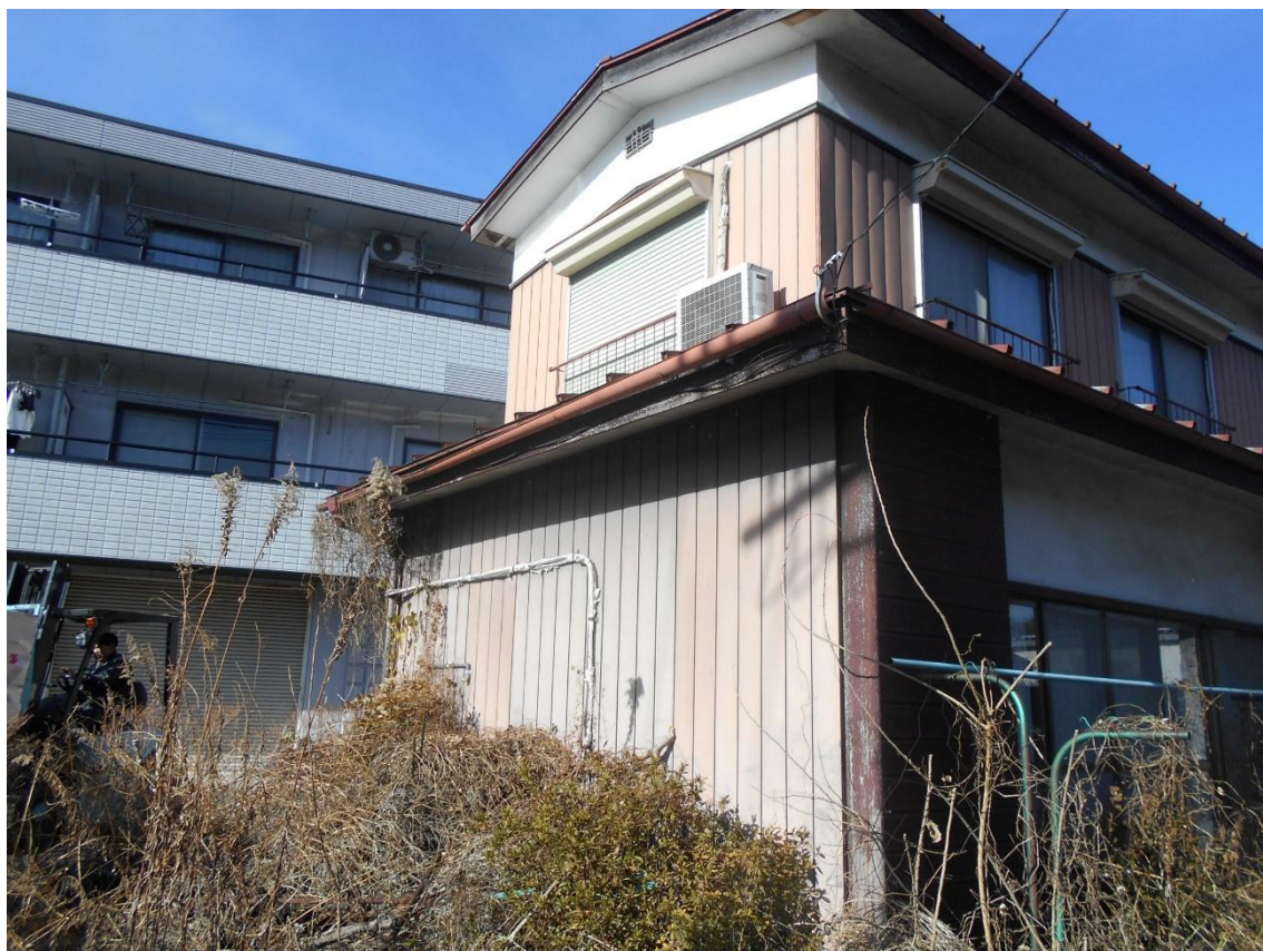
① 物件を北側から撮影
