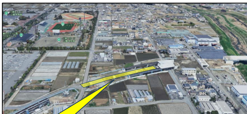
工事施工箇所
