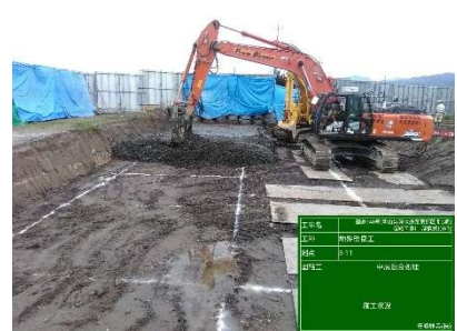
地盤改良工 施工状況
