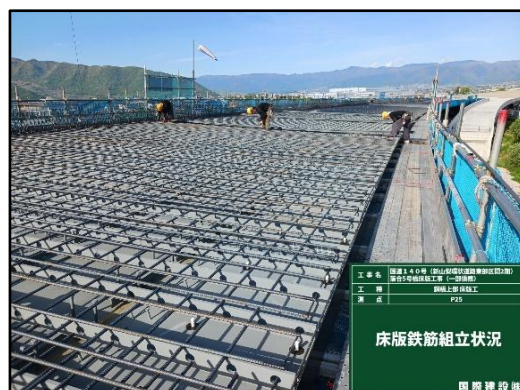
床版鉄筋 組立作業
