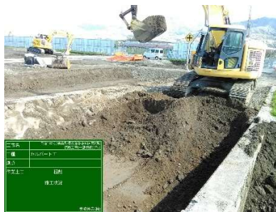
函渠工 掘削
