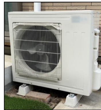
エアコンディショナーの室外ユニット 及び電気温水機器のヒートポンプ
