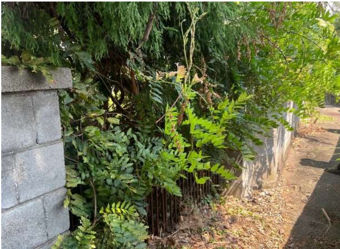
⑥対象土地 南側から北北東方向（門あり）
