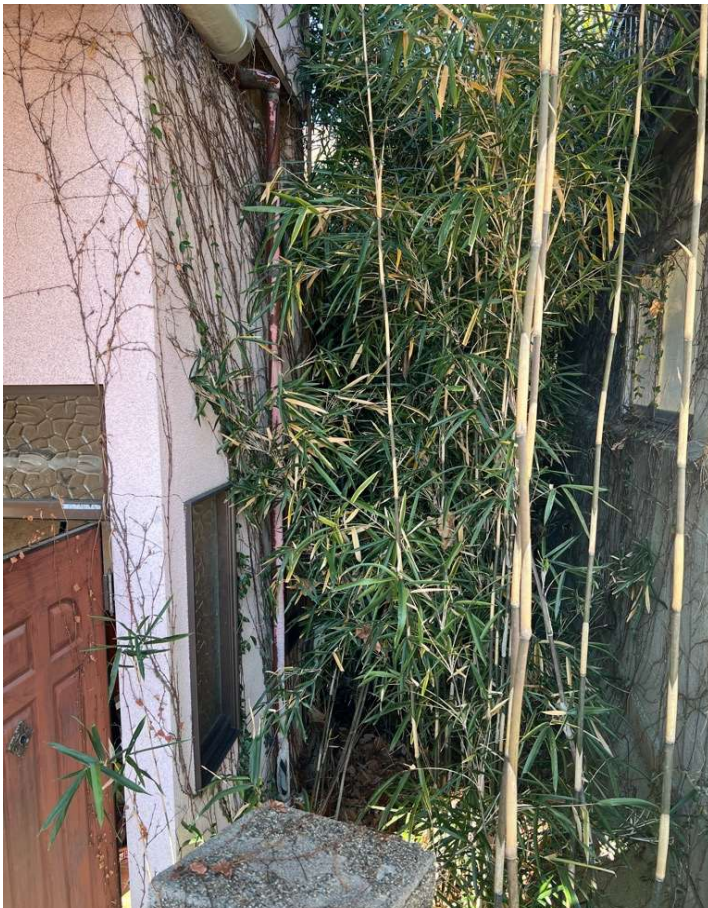
⑥対象物件東側より隣地との境界
