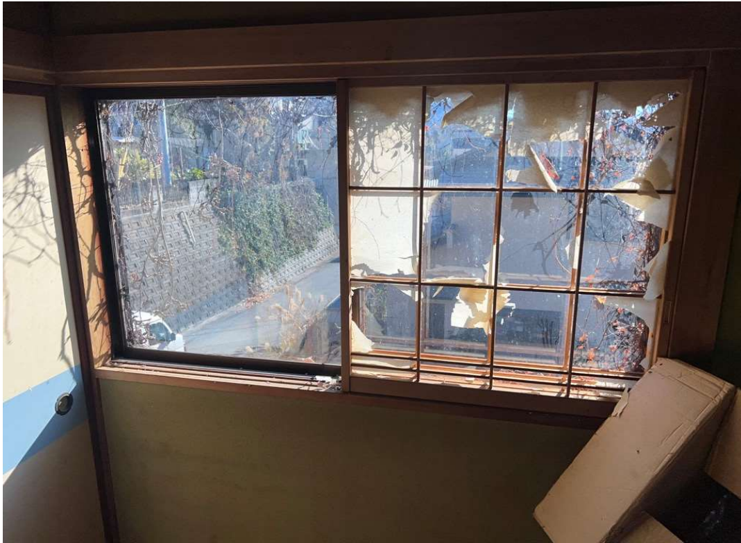
③⑩対象物件内2F和室3南東方向
