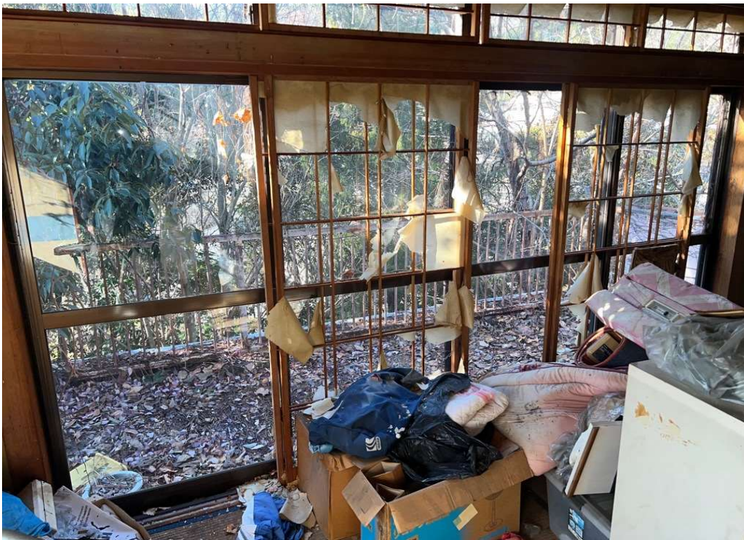
③対象物件内2F和室3西方向
