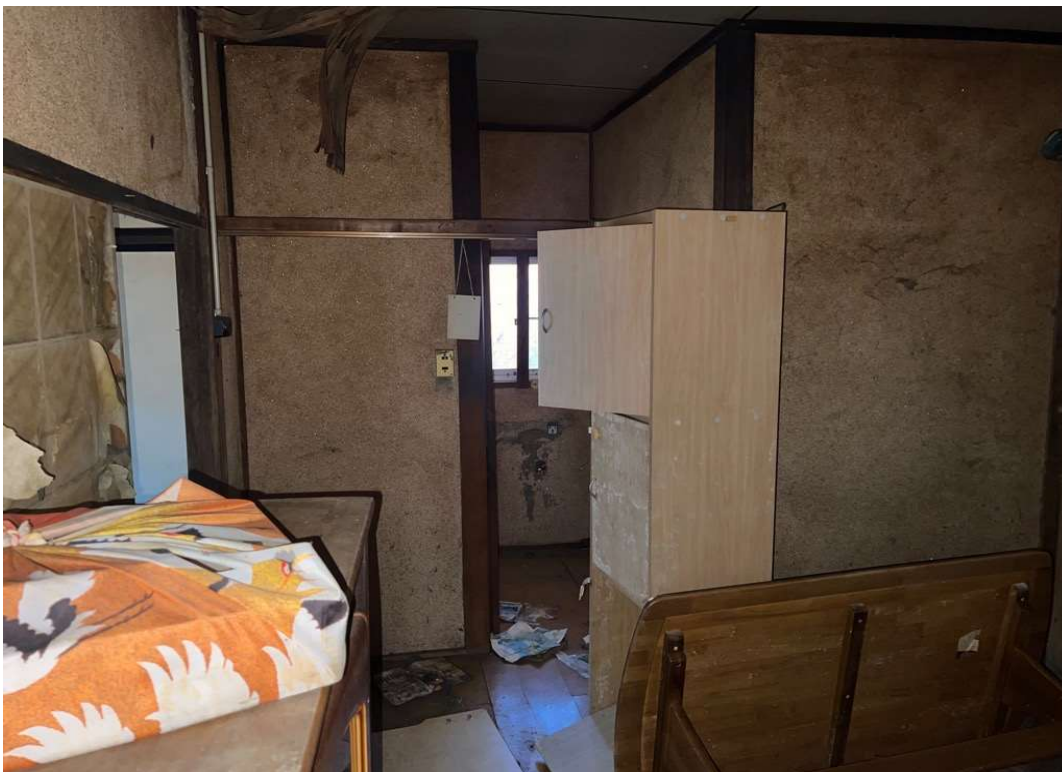
⑯対象物件内ダイニング中央より北西方向
