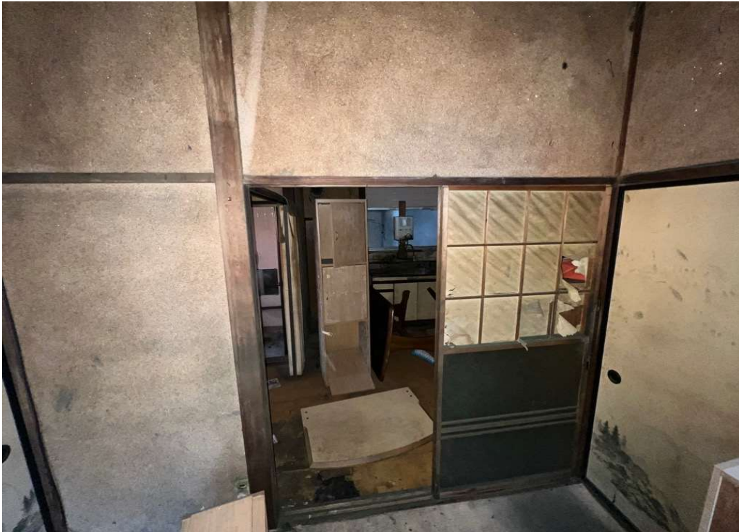
㊸対象物件内和室2 北東方向
