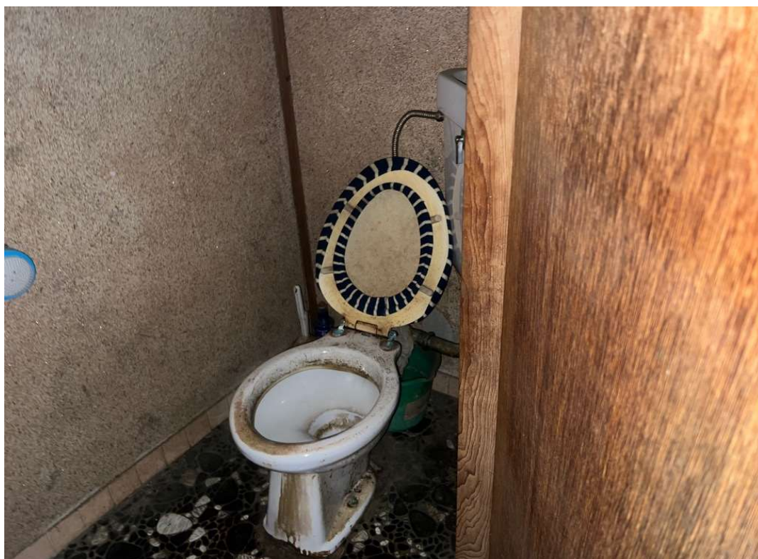
⑰対象物件愛1Fトイレ
