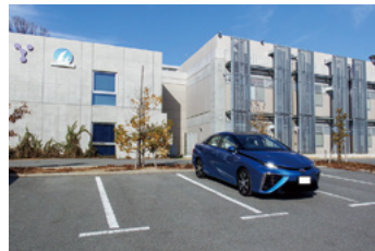
① 山梨大学 水素・燃料電池 ナノ材料研究センター
