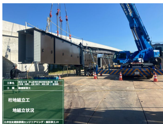
鋼桁地組立状況
