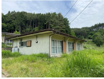
写真7 移築前の建物
