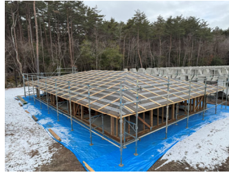
写真8 移築後の建物
