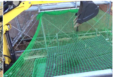
写真2 重機を用いた検証
