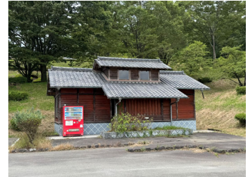
写真4 高原町の建物の様子
