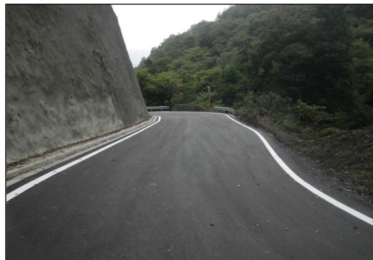
② 完成状況
