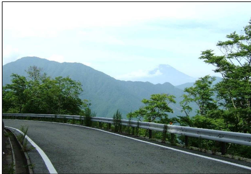
② 完成状況
