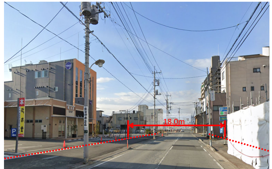
②現道の状況 用地取得できた箇所から道路工事に着手している（南を望む）
