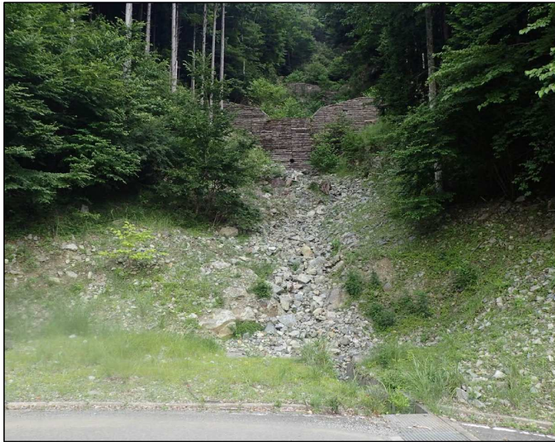
⑨ 治山施設
