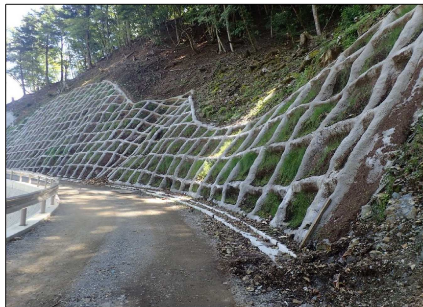
⑧ 法面保護工の実施状況
