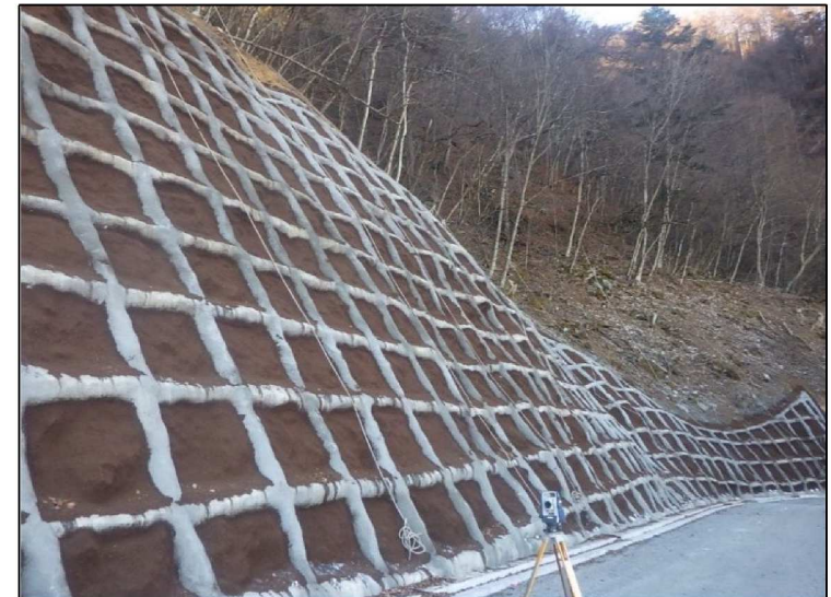
簡易法枠工の完成状況
