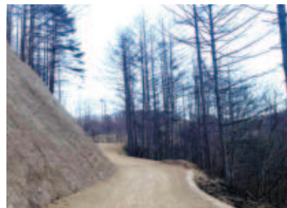
■ 林道及び林業専用道の開設
