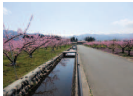
■ 農業用排水路整備
