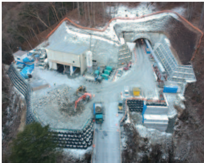
■ 国道411号 一之瀬高橋バイパス 整備中のトンネル
