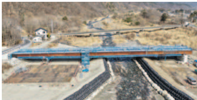
■ (一)横手日野春停車場線 駒城橋架替
