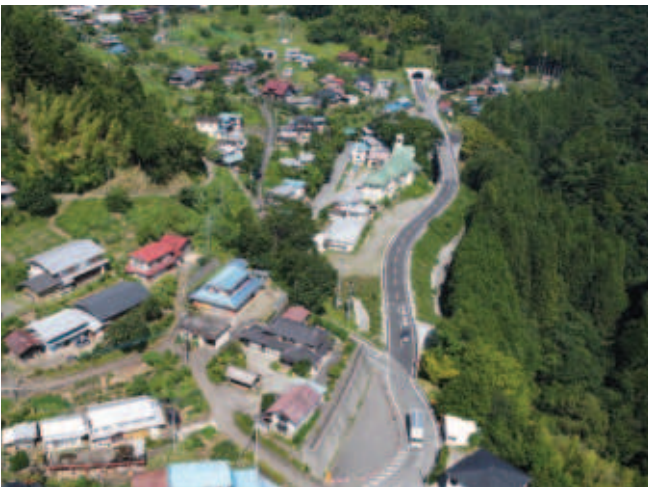
■ 国道139号 上和田バイパス 供用区間
