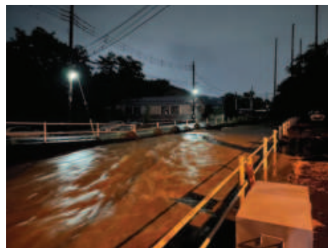
令和6年8月7日 1級河川貢川 甲斐市大下条
