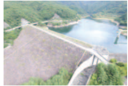
■ ドローンによるダム点検映像
