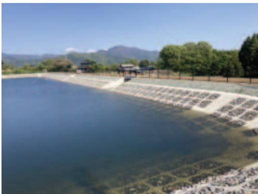
■ 耐震化された防災重点農業用ため池
