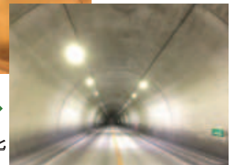
■ トンネル照明のLED化
