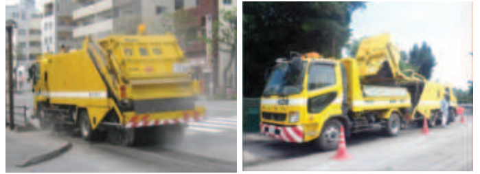
■ 路面清掃車による降灰除去
