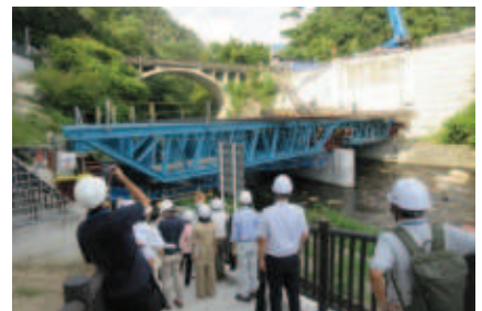
■ 公共事業評価委員会による現場視察
