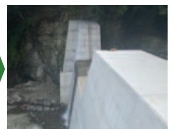
■ 砂防堰堤の改築
