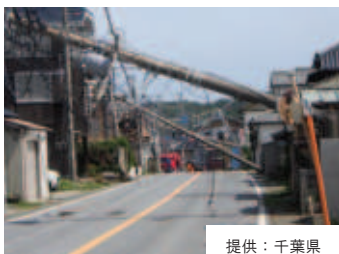
■ 令和元年台風15号による電柱倒壊
