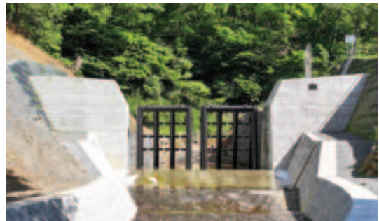
■ 土砂災害を防止する砂防堰堤
