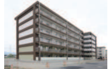
■ 県営住宅の建替
