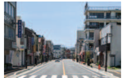
■ 無電柱化された道路
