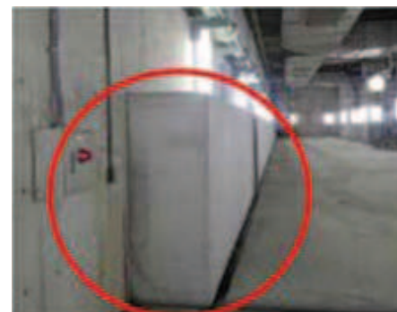
■ 下水処理場の耐震化
