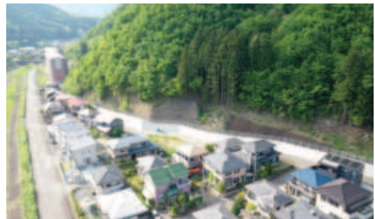
■ 人家を守る急傾斜地崩壊防止施設
