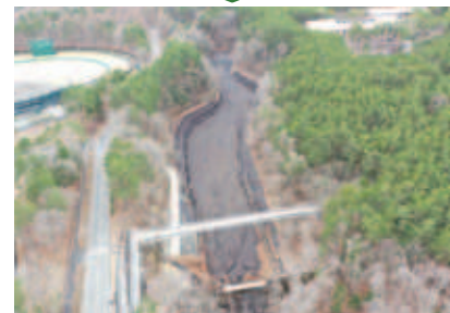
■ 土砂を捕捉した堰堤
