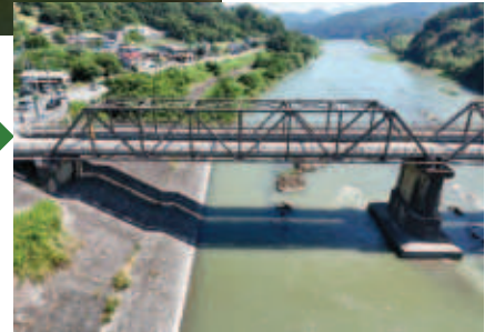
■ 県管理道路における橋梁補修
