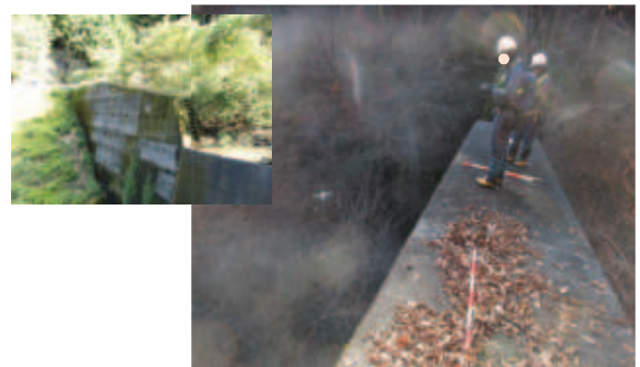
■ ドローンを用いた砂防堰堤の点検
