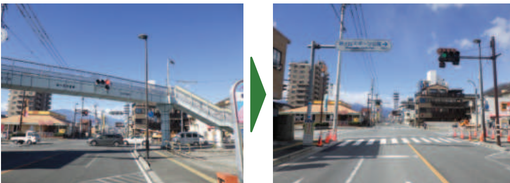
■ 歩道橋の撤去
